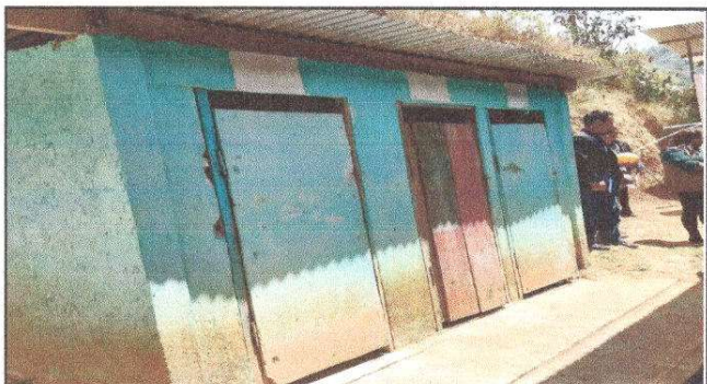
Foto 3: Sustrucción de puertas de servicios sanitarios
