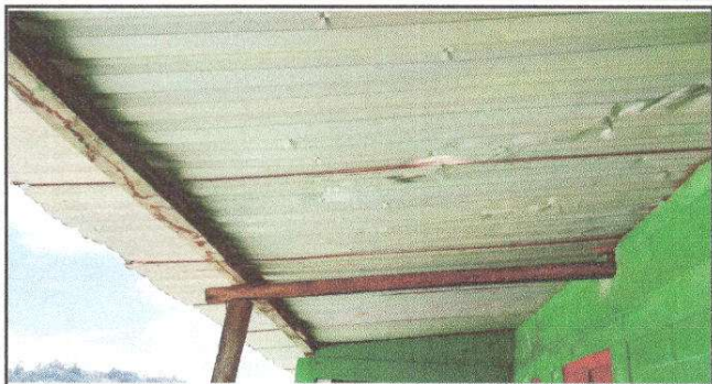
Foto 1: Sustrucción de lámina, por lámina torquelada aluzinc calibre 26
