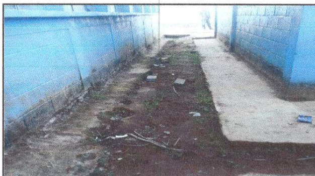
Foto 4: Sustrucción de piso de torta de concreto
