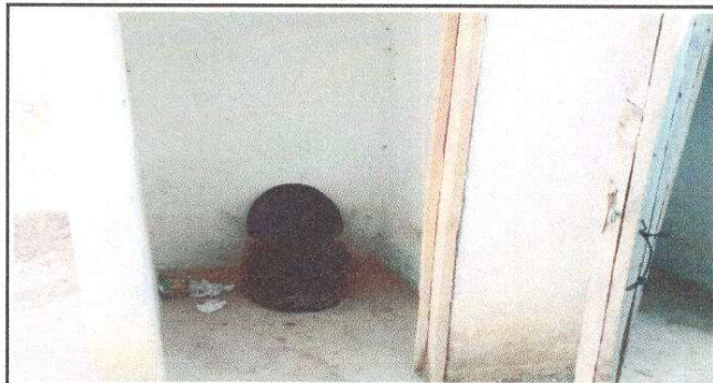
Foto 1: Sustrucion de inodoro de taza plastica, por taza lavable
