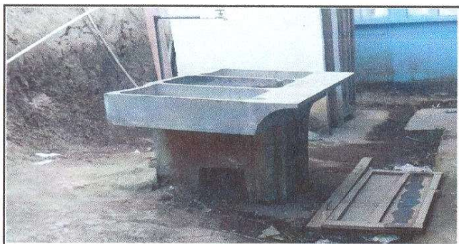
Foto 3: Sustrucion de pila de concreto por pila plastica de 2 lavaderos
